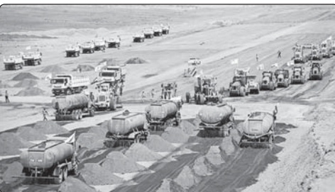
تکمیل شدن بخش‌هایی از آزادراه شیراز-اصفهان در حال احداث است. در زمان حاضر اگر یک هزار میلیارد تومان بودجه تأمین شود، این پروژه جمع بندی می شود و اگر ظرف یک تا دو ماه باقی مانده از فصل کاری اعتبارات تزریق شود، رونق خوبی برای وضعیت اجرایی پروژه خواهد داشت
